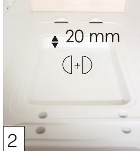
2 Die Mitte anzeichnen und den Sockelboden mit einem 46 mm Topfbohrer aufbohren.
